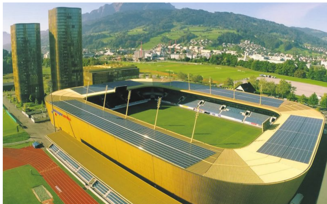
Eine der grössten von der BE Netz AG realisierten Photovoltaikanlagen ist jene auf der Luzerner Swissporarena. FOTO ZVC
