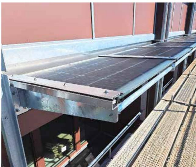
Rechts: Das 24-stöckige Gebäude wurde in Holz-Hybrid-Bauweise erstellt. Die Solarmodule wurden jeweils in horizontal auskragender Stellung an der Fassade über den Fenstern angebracht. BILD STUDIOLÖMEN
