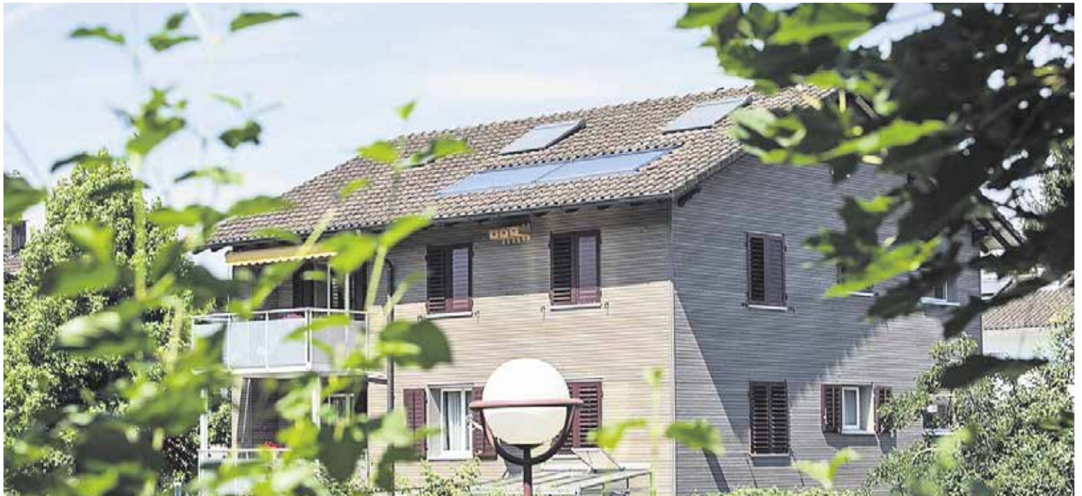
Das Warmwasser wird mit einer thermischen Solaranlage mit dachintegrierten Kollektoren erzeugt.
