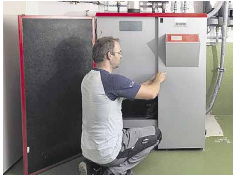
Die alte Ölheizung wurde durch eine neue Pelletheizung ersetzt.
